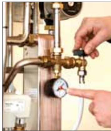
Manometern visar om det är rätt tryck i värmesystemet.
